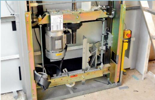
**1** Zuerst wird die Rückwand des selbsttragenden Schachtes aufgebaut. Davor die Fahrinheit mit dem 2,2 kW Motor.
