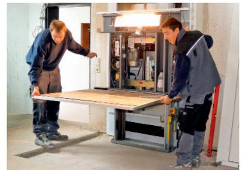
**6** Die Monteure nehmen die Ausrichtung der Plattform auf der unteren Haltestelle vor.
