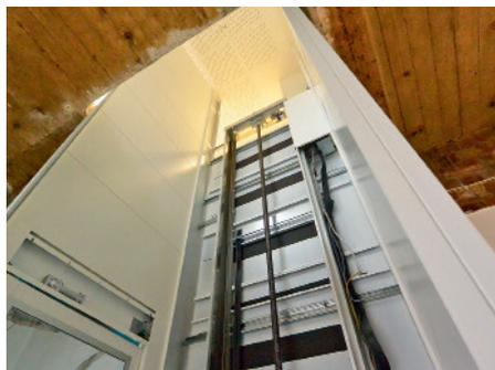
**12** Bei einem geschlossenen Schacht kann als Option eine Innendecke bestellt werden. Die Innendecke hat eine gut integrierte LED-Beleuchtung.
