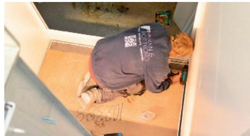
**9** Sicherheitsleisten um die Plattform und Plattformwand verhindern, dass etwas zwischen der fahrenden Plattform und dem Schacht bzw. den Wänden stecken bleibt.
