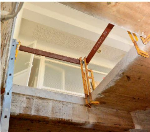
**4** Ein Architekt ist für den Umbau nicht notwendig. Für Durchbrüche in vorhandene Decken bei nachträglichem Einbau ist eine Statik einzuholen.
