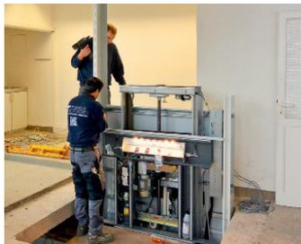
**8** Die Schachtverlängerung für die Schachtplatten auf der obersten Haltestelle werden angebracht.
