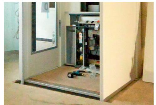
**13** Die Schachtplatten bestehen aus Stahlblechen mit Polystyrol-Kern. Sie gibt es in unterschiedlichen Höhen und können optional mit einem Kern aus Steinwolle statt EPS bestellt werden.
