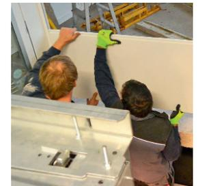
**10** Die Schachtverkleidung wird von der fahrenden Plattform aus aufgestellt.
