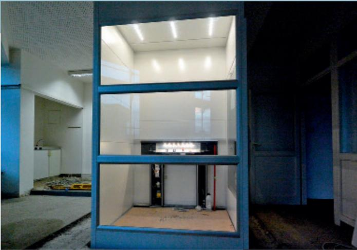
**1** Optional können die Sandwichplatten durch Glas ersetzt werden. Standard ist dabei Klarglas. Auch Farbglass ist erhältlich. Die Gläser sind in Aluprofile eingepasst, die ebenfalls optional in einer RAL-Farbe lackiert werden können.
