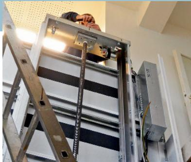
**2** Die Spindel, an welcher die Plattform auf und ab fährt, muss genau justiert werden, damit der Aufzug reibungslos fährt.
