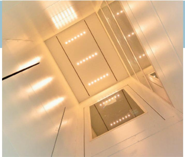
**2** Die Schachtdecke mit der schicken LED-Beleuchtung. Links im Bild: die Schachtseite, an der die Plattform auf und ab fährt und vorne die Tür mit einer großen Glasscheibe.
