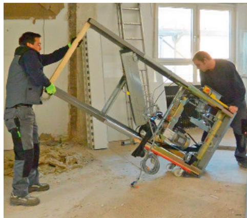
**5** Die vorgefertigten Module werden von erfahrenen Monteuren aufgestellt. Bei fast allen Modellen lässt sich das Material durch eine normale Haustür hineinbringen.
