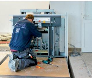
**7** Die Ausrichtung der Plattform auf der oberen Haltestelle.
