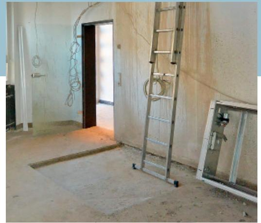
**3** Für das Aufstellen des Aufzugs wird lediglich eine 50 mm tiefe „Grube“ benötigt. Ist diese nicht möglich, kann der Plattformlift auch direkt auf dem Boden aufgestellt werden und eine 50-mm-Rampe ermöglicht den barrierefreien Zugang.
