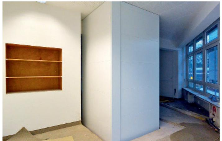
**4** In der oberen Etage kann man gut den selbsttragenden Schacht sehen. Spezielle Schachtstützen wurden nicht sichtbar eingebaut, da dieser hier nicht gegen eine Wand montiert wurde.
